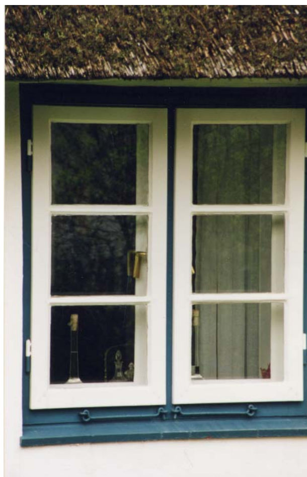
Kastenfenster in einem Haus in Norddeutschland
